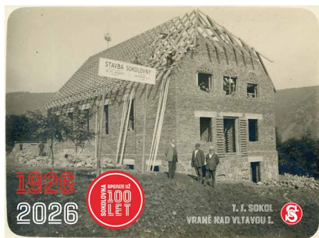
Stavba sokolovny v roce 1926. Foto: archiv T. J. Sokol Vrané nad Vltavou I.
